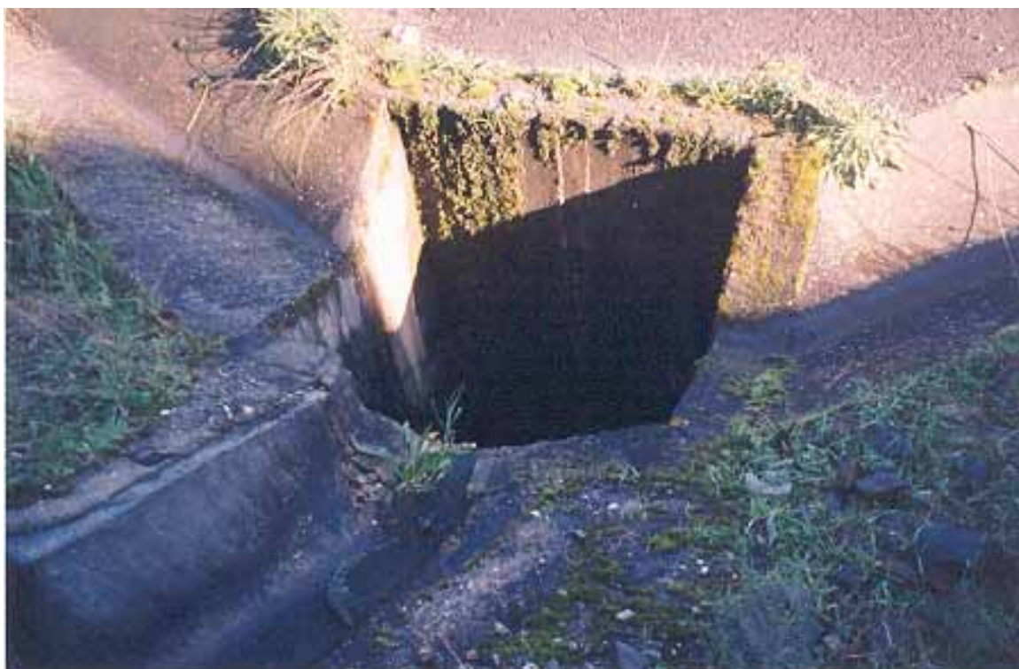
Figura C12 – Estrutura de entrada em recipiente.
