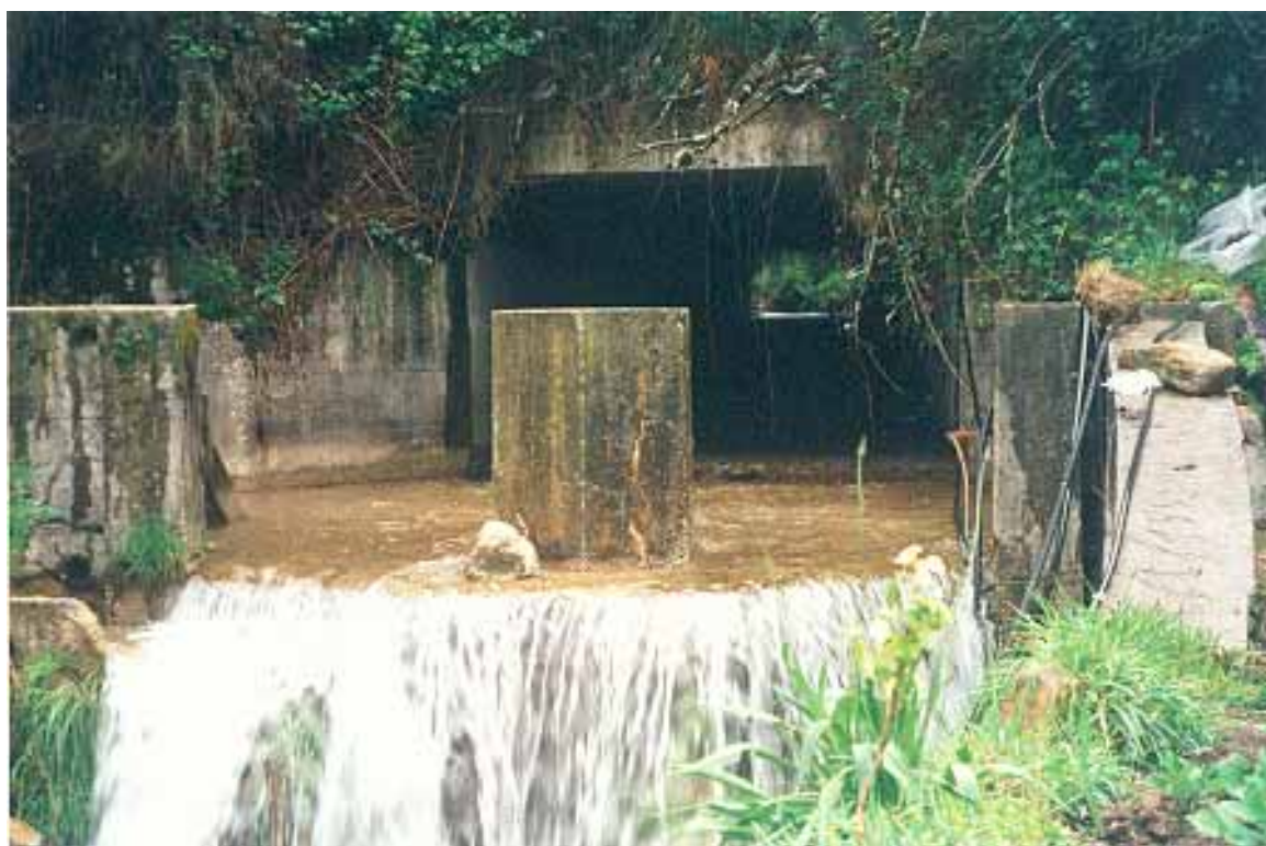
Figura C4 – Aqueduto de secção rectangular.
