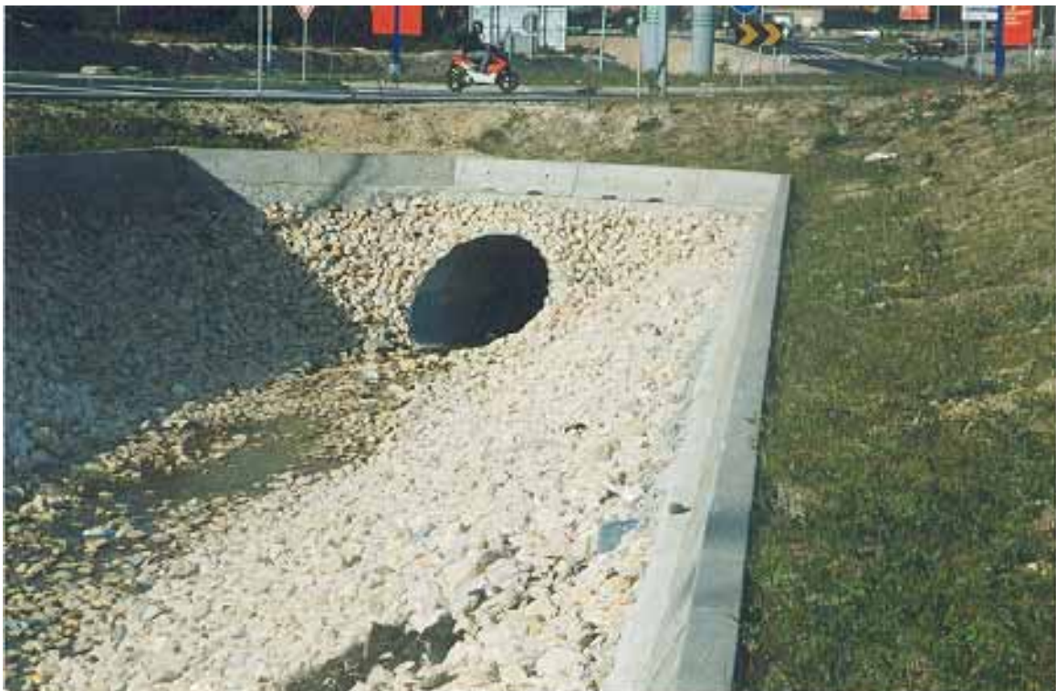
Figura C6 – Aqueduto em tubo metálico corrugado ( corrugated pipes ).
