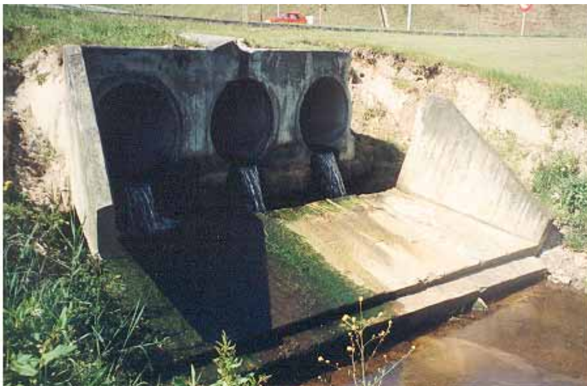
Figura C13 – Efeitos da ausência de dissipador de energia adequado num aqueduto de secção circular triplo.
