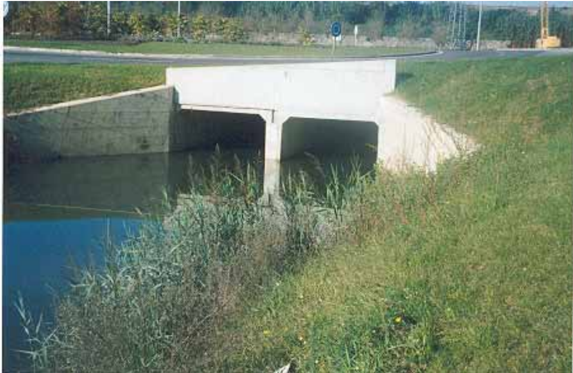
Figura C5 – Aqueduto duplo de secção rectangular.
