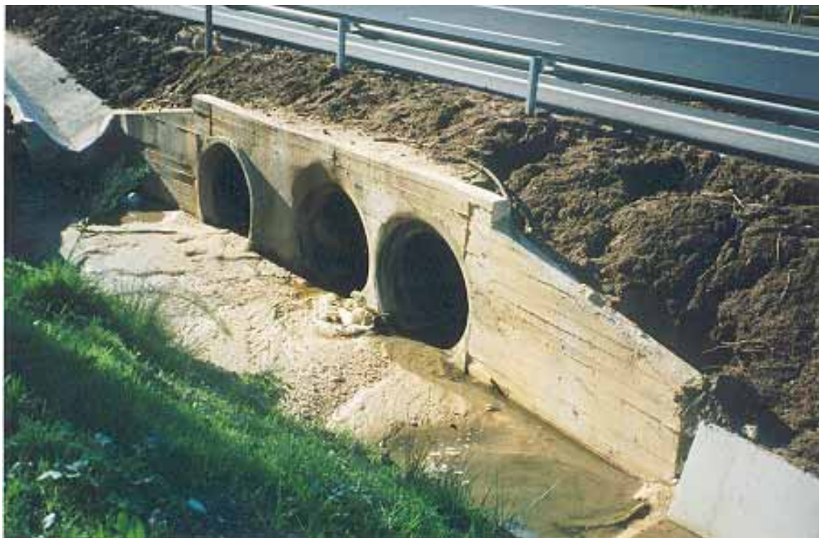
Figura C3 – Aqueduto triplo de secção circular.
