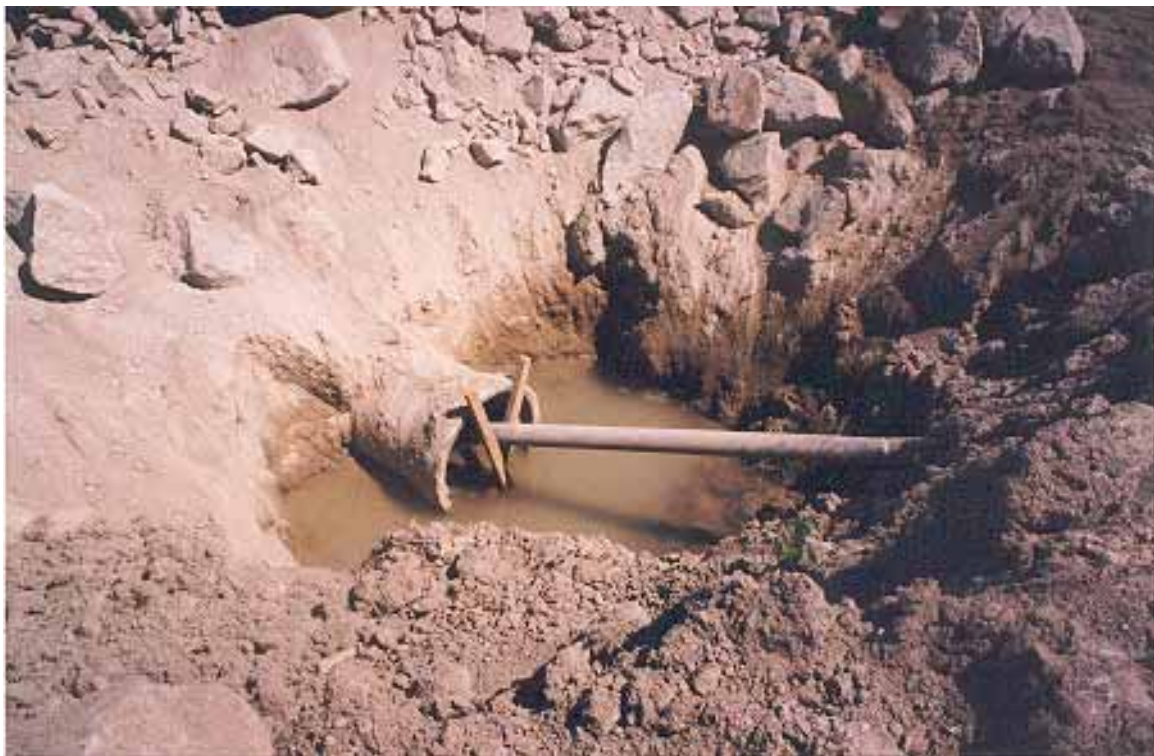
Figura C8 – Construção de aqueduto de secção circular.
